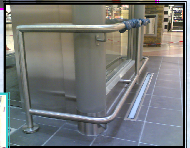
Garde corps de protection en partie basse Ø 50mm ép 3 mm fixations invisibles
